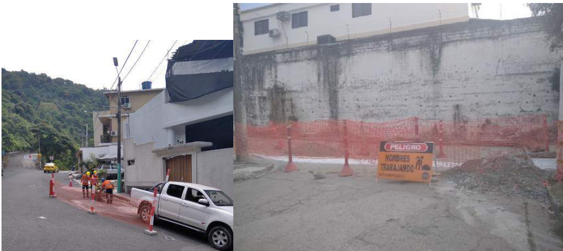
Ilustración 12. Señalización de obras. Fotos de la autora
