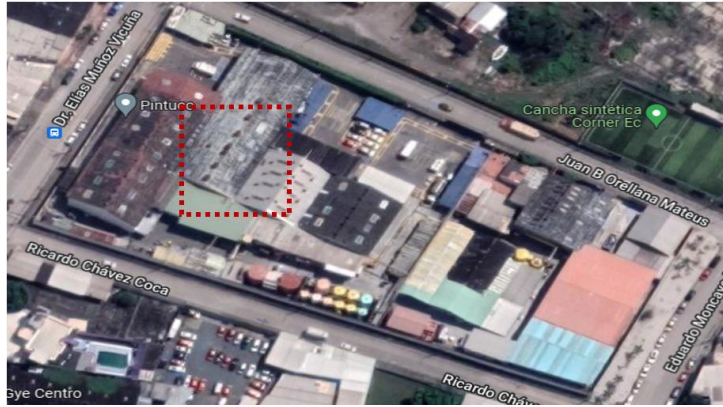
Ilustración 2 Imagen del área de ubicación de máquinas de termocongado
